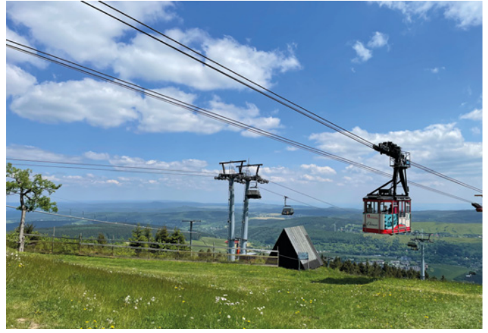
Die Fichtelberg-Schwebekabine überwindet von der Talstation bis auf den Berg auf einer Länge von 1.175 m einen Höhenunterschied von 303 m. Genießen Sie während der Fahrt den herrlichen Ausblick auf das Tal und die Skisprungschanzen. Bilder: Daniel Herold
